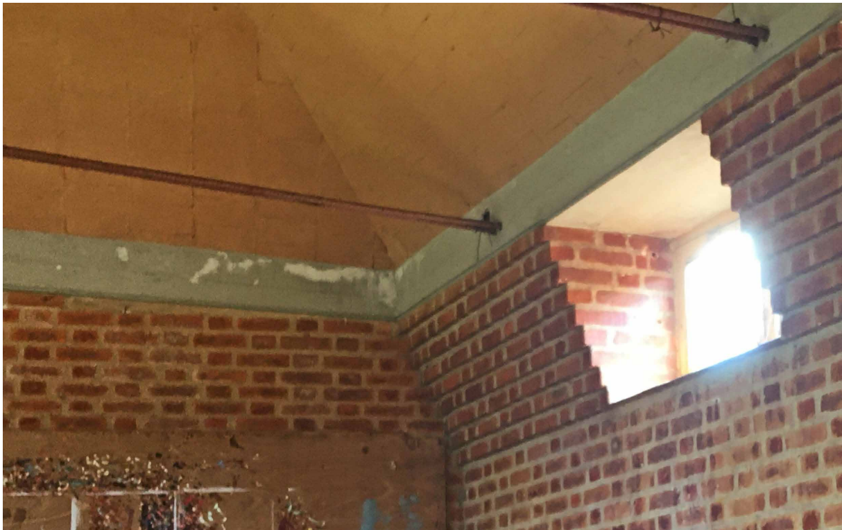
Detalle del aumento de la profundidad del muro mediante escalones
